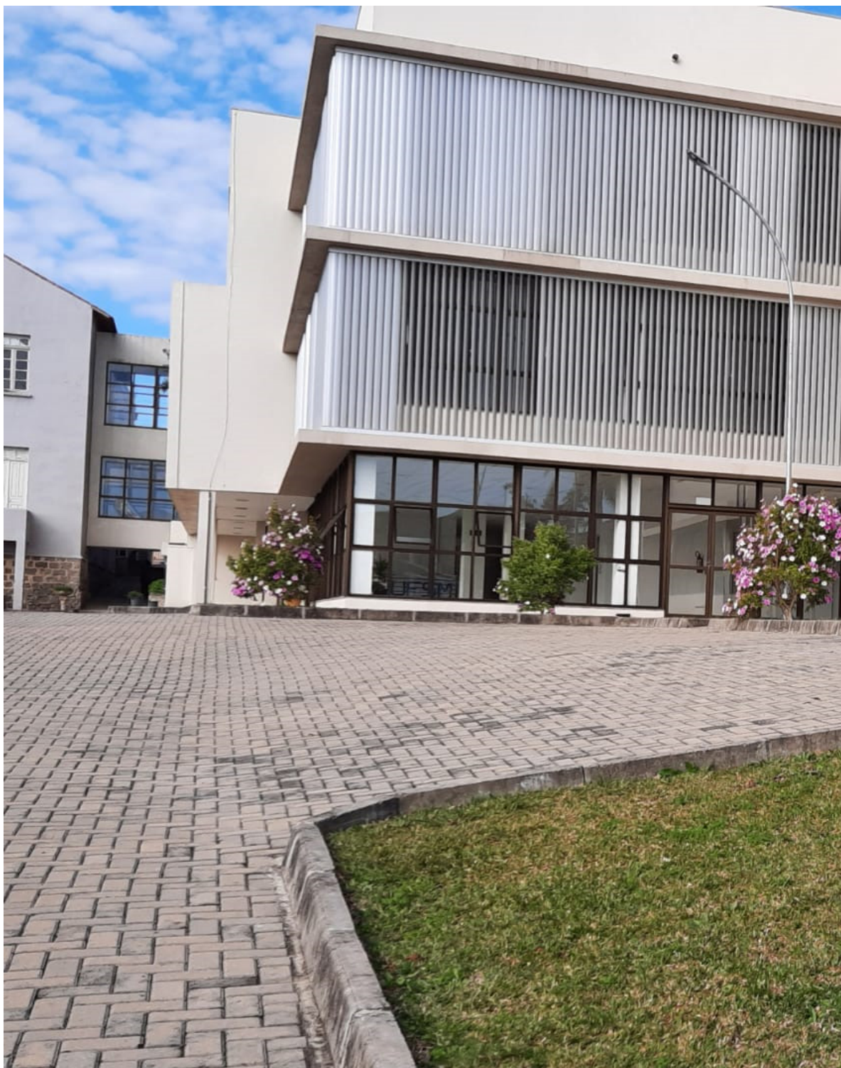
Foto da Capa: Antigo acervo do CDM no Bloco A do Espaço Multidisciplinar UFSM Silveira Martins. Foto da Quarta Capa: Vista da Entrada 2 da UFSM Silveira Martins, com vistas ao Bloco B, onde fica a atual Sala de Guarda dos Acervos do CDM.
